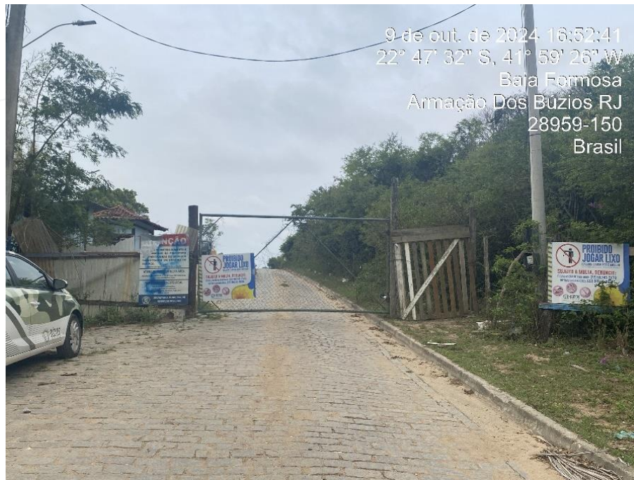
Figura 61 - Estação de Transbordo do Município – Entrada.
