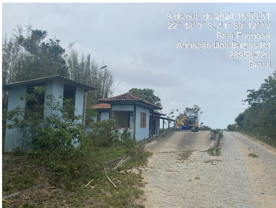
Figura 60 - Estação de Transbordo do Município - Guarita.
