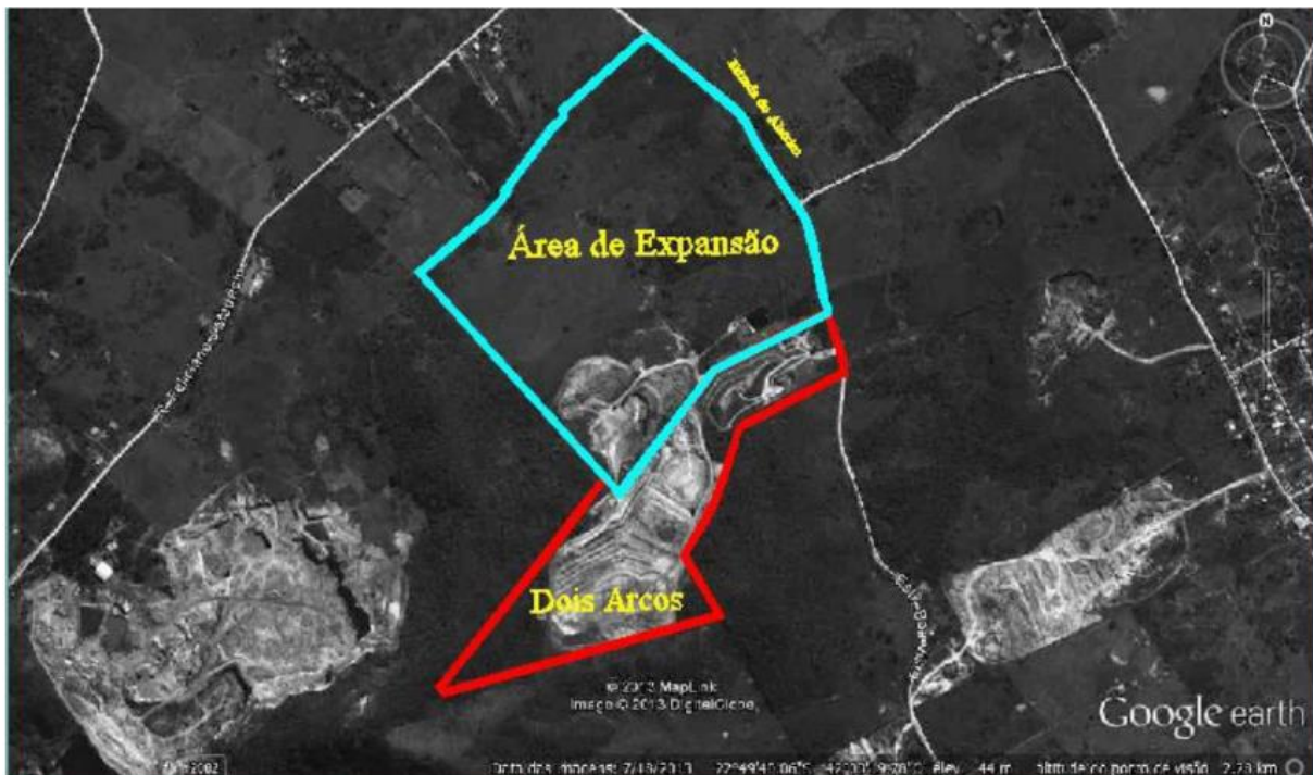
Figura 62 - Etapa inicial e área de expansão do aterro sanitário.
